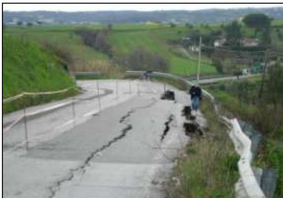
Fig. 3 - Cedimento di parte della carreggiata della strada per Roggiano Gravina (Contrada Timpone).
