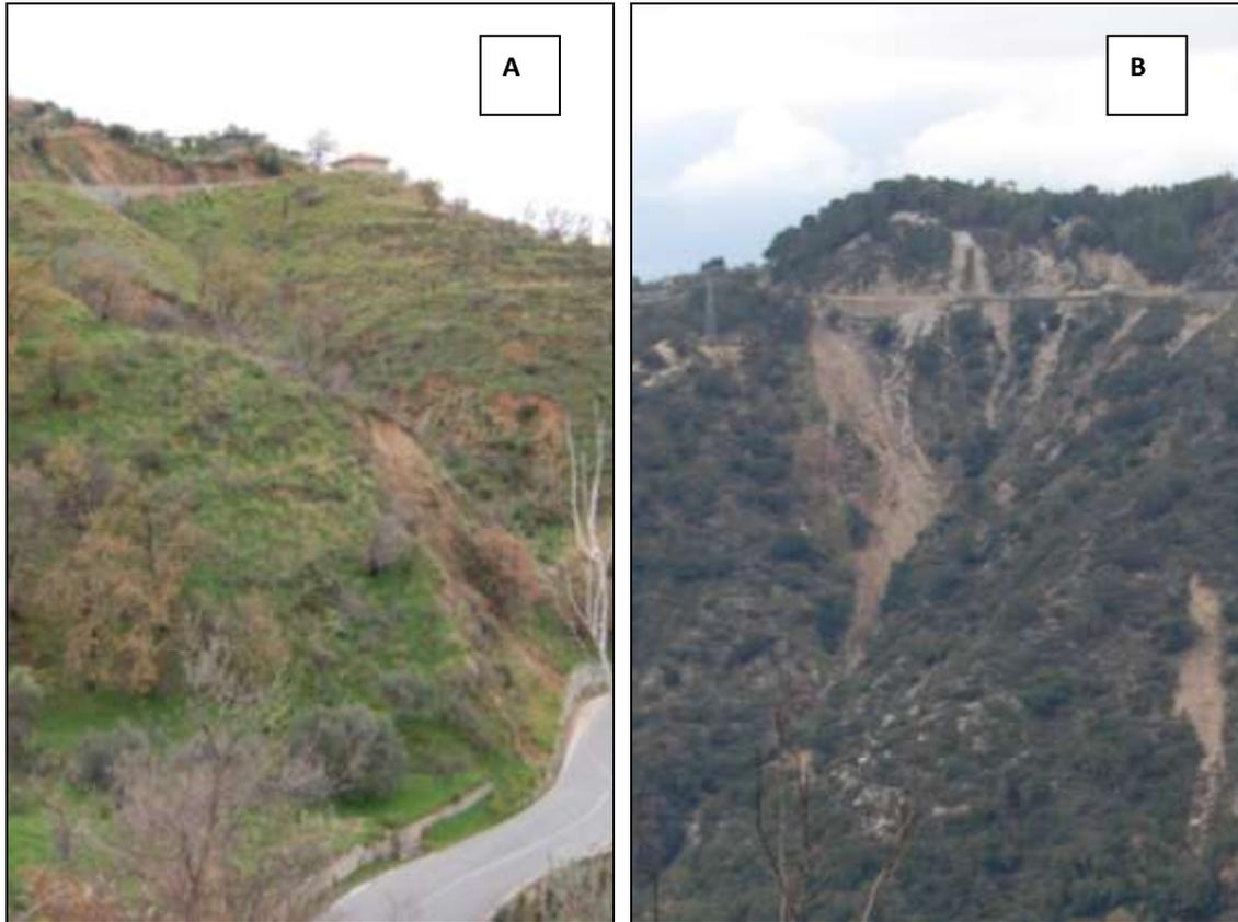
Fig. 4 – Fenomeni franosi superficiali lungo la strada di accesso all’abitato di S. Andrea Apostolo dello Ionio (foto A) e lungo la strada che conduce all’abitato di San Sostene (foto B).
