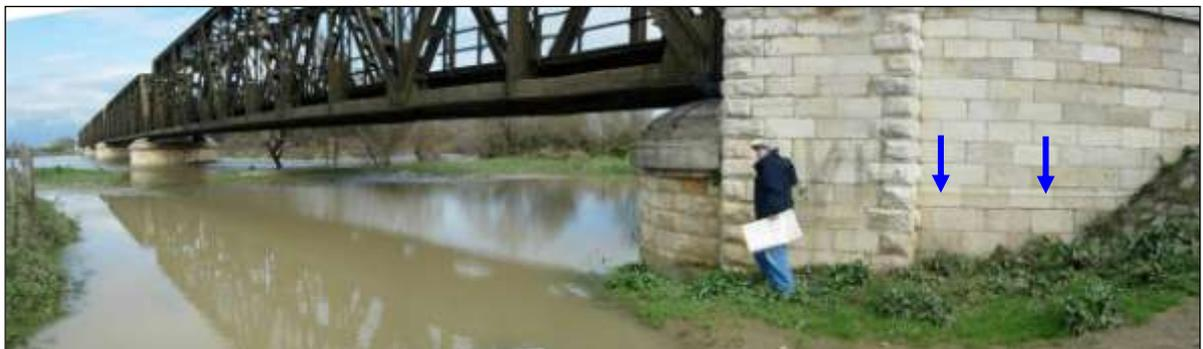
Fig. 23 - Ponte ferroviario sul fiume Crati (punto 3 in figura 20). Le frecce blu indicano il livello raggiunto dalle acque di piena.
