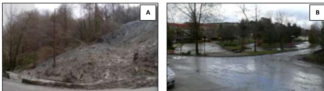
Fig. 6 – (A) Frana che ha ostruito la canalizzazione provocando la fuoriuscita dell'acqua. (B) Segni evidenti del passaggio di fango e detriti nella piazza di contrada Cona (Malito).
