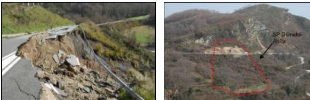
Fig. 10 - Fenomeni franosi mediamente profondi che interessano la rete stradale principale, nei dintorni di Altita.
