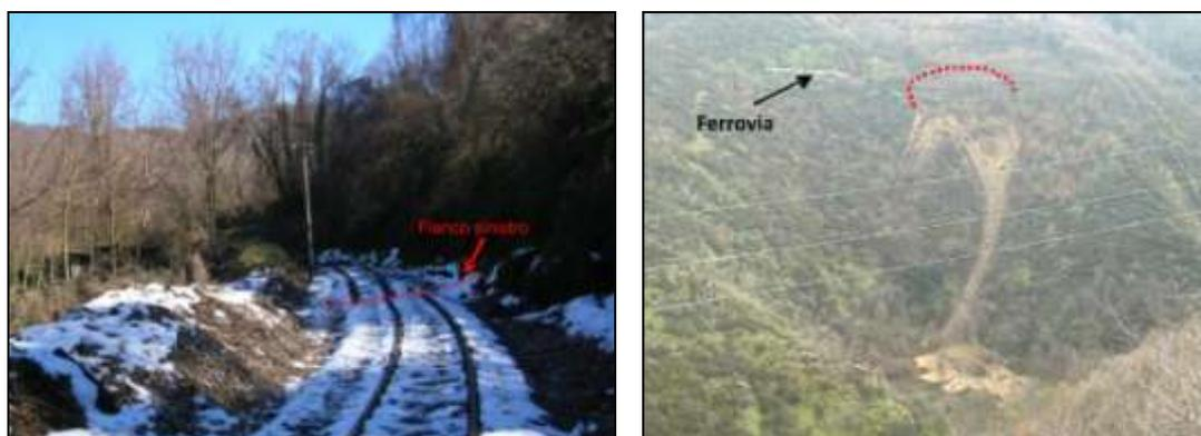
Fig. 11 - Fenomeni franosi mediamente profondi che interessano tratti di ferrovia rispettivamente nei pressi dell'abitato di S. Stefano di Rogliano (foto a sinistra) e nei pressi dell'abitato di Carpanzano (foto a destra).
