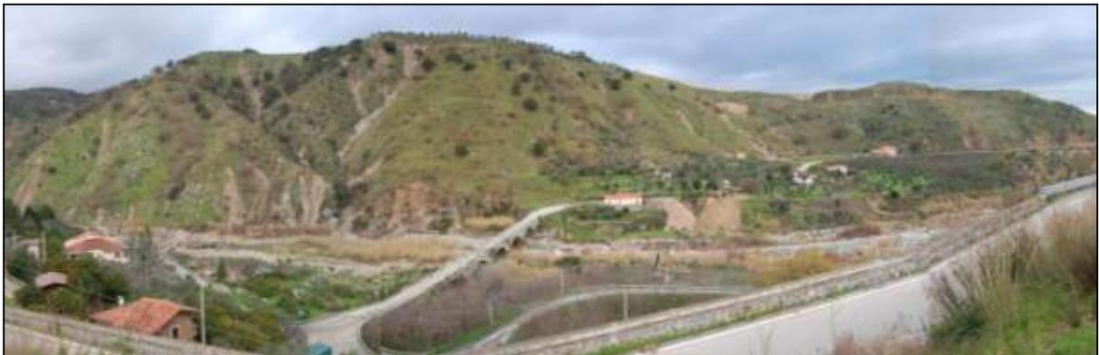
Fig. 5 - Versante in sinistra idrografica della F.ra Ancinale, nei pressi del ponte della SP 128 che conduce all’abitato di Satriano. Sono visibili i molteplici fenomeni franosi superficiali che hanno interessato il versante a monte della strada.
