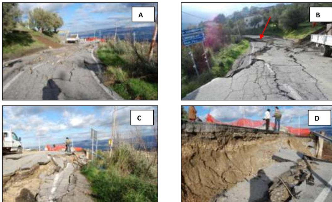
Fig. 14 – Frana che ha interessato un tratto della SP 94 nel comune di San Vincenzo la Costa nei pressi del bivio per Cosenza. A) panoramica generale del movimento franoso; B) fianco destro; C) fianco sinistro; D) particolare della scarpata di frana che ha interessato la sede stradale.
