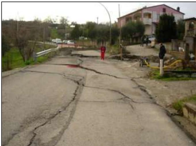
Fig. 6 - Rotture dell'asfalto e della rampa di accesso ad una abitazione causate dalla frana di località Pianette.
