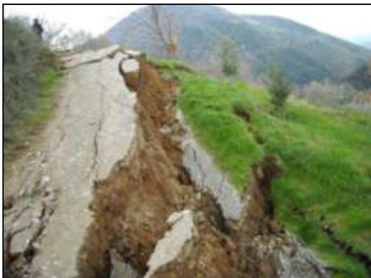
Fig. 11 - Rotture multiple al piede della frana.
