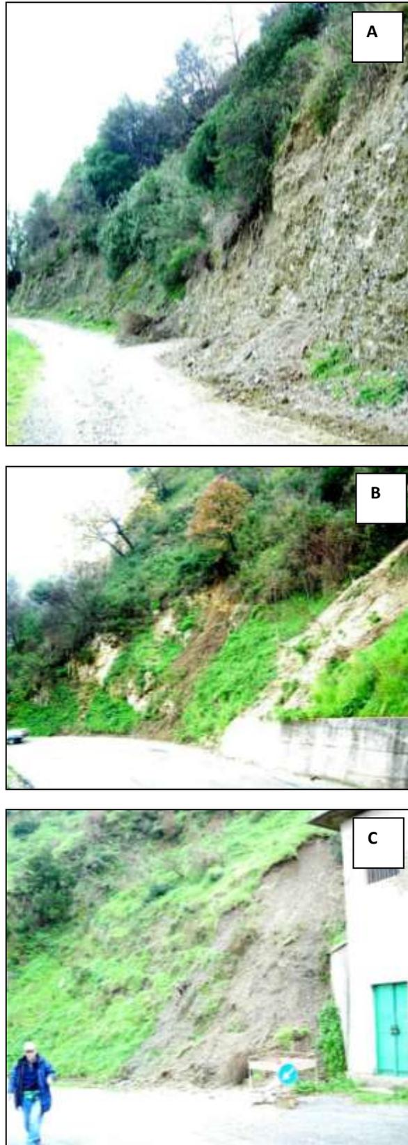
Fig. 4 – A) Strada di accesso al cimitero di Grotteria. Soil slip su rocce sedimentarie grossolane; B) SP 501 al km 38, ingresso sud di Grotteria. Soil slip di materiale detritico su calcare evaporitico; C) SP 501 nei pressi del serbatoio idrico. Soil slip su sabbie e conglomerati.
