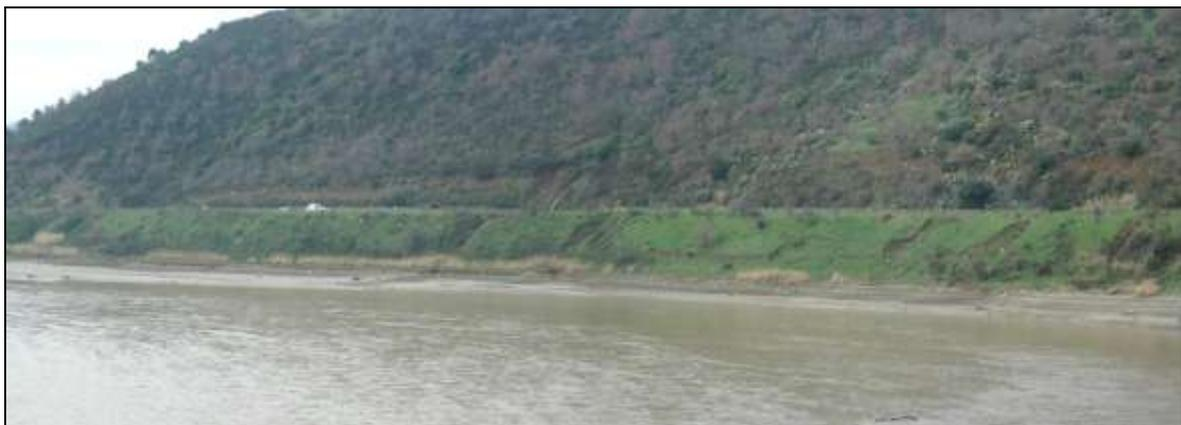
Fig. 18 - Dissesti superficiali lungo la sponda sinistra del Lago di Tarsia (punto 1 in figura 17). Il materiale coinvolto sembra in prevalenza terreno di riporto del lato di valle del taglio stradale.
