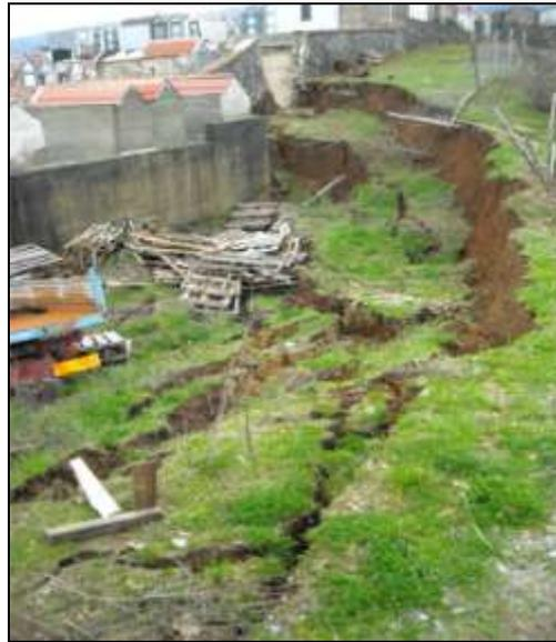
Fig. 8 - Frana del Cimitero di Fagnano Castello: settore sinistro della scarpata principale e della testata di frana.
