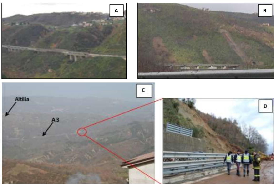
Fig. 7 – Fenomeni franosi superficiali osservati lungo il tracciato della A3 Salerno-Reggio nei pressi di Cosenza (A e B) e nei pressi di Altília (C). Nella foto D la frana che il 25 gennaio causò la morte di due persone.
