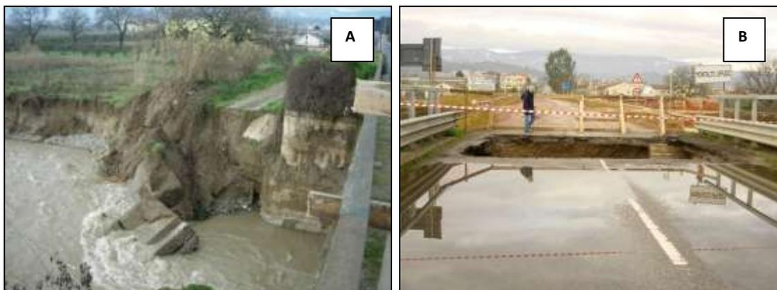
Fig. 16 - Cedimento del ponte della SS 279: punto in cui le acque hanno concentrato la loro azione erosiva (A) e voragine apertasi nell'asfalto (B).
