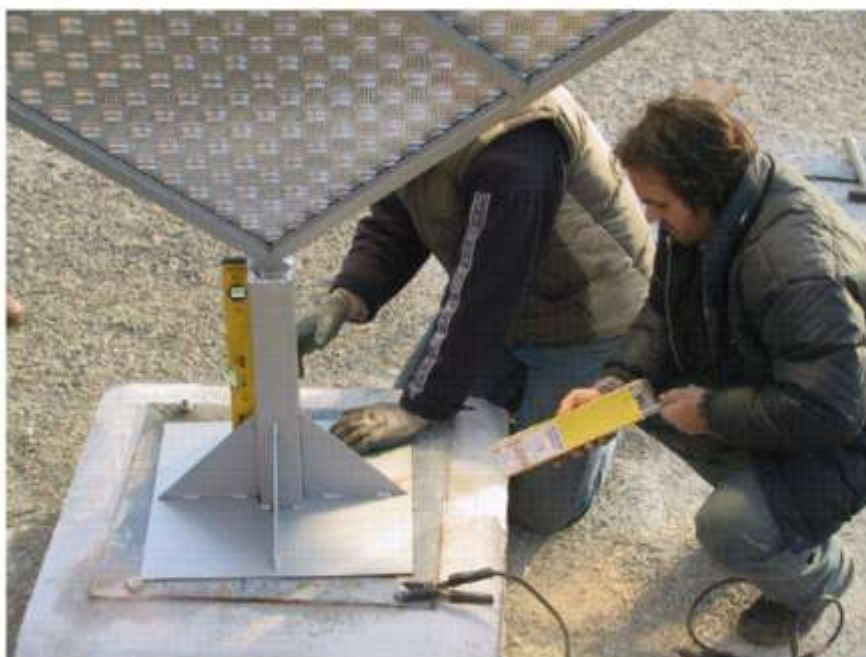
Primo fissaggio con controllo della verticalità del supporto
