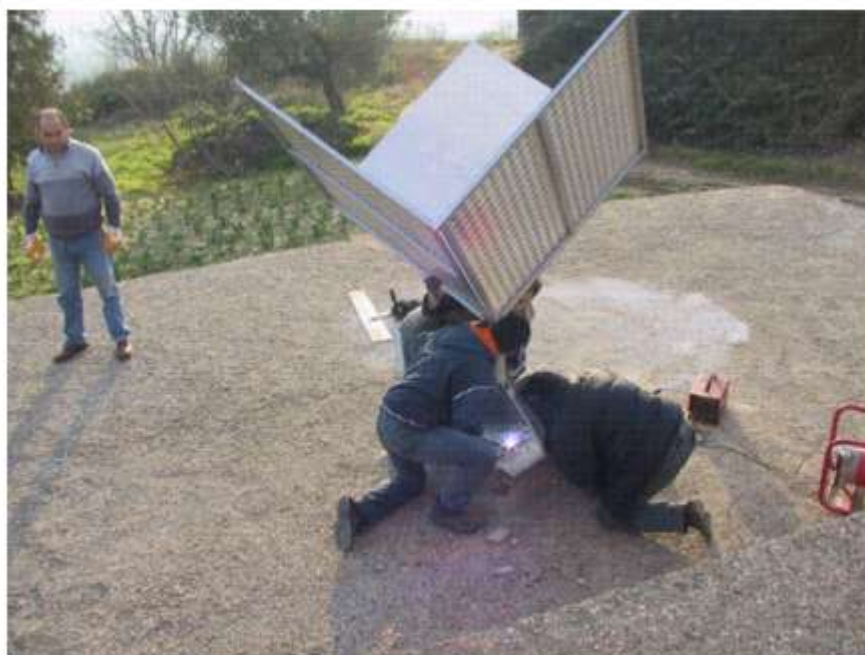
Fissaggio con mantenimento della verticalità
